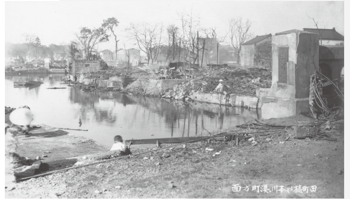
田町橋付近(現、朝日本町)
