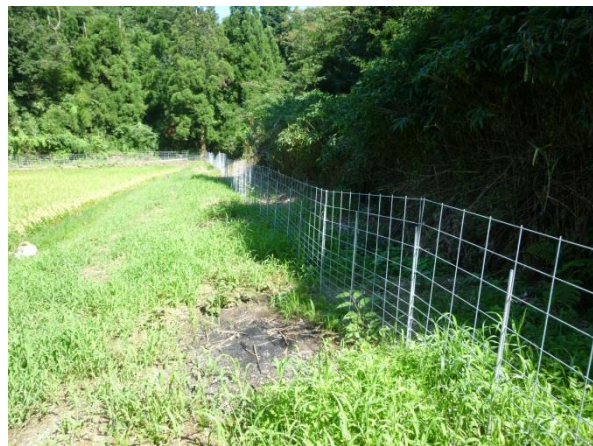
【集落の外周に侵入防止柵を設置】
