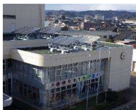
公共施設に設置した太陽光パネル
