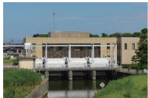
十二町瀉排水機場
