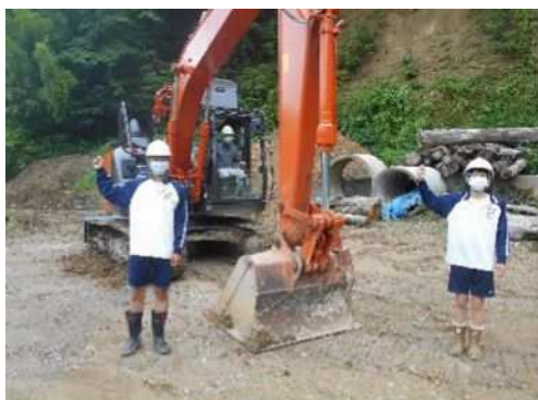
砕石場での作業体験
