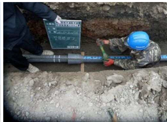
図 6.3.7 耐震管の施工例
