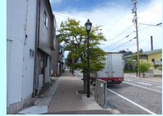
道路照明整備
