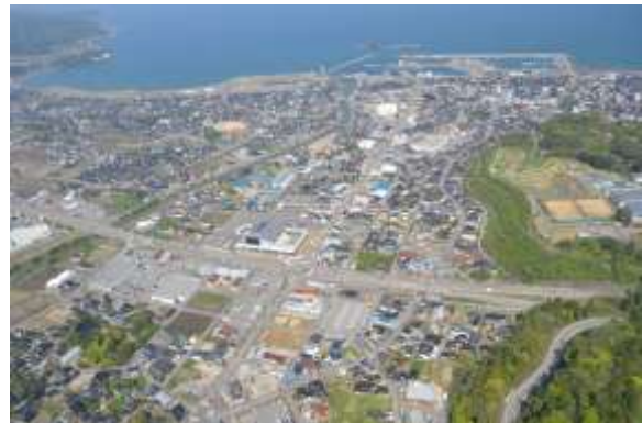
空から見た国道 415 号
