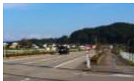
国道 415 号（氷見 IC～氷見漁港付近）
