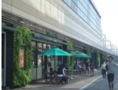
接道部に設けたオープンスペース
