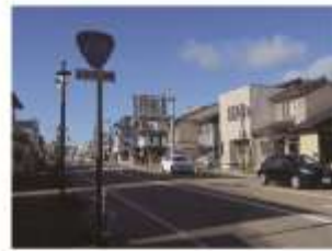
住宅・併用住宅の並ぶ区間
