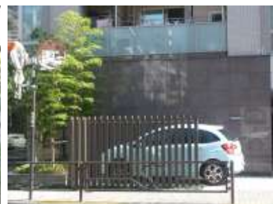
周囲にルーバーを設けた屋外駐車場
