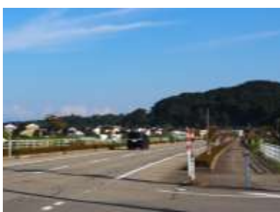
国道415号の街路樹と防護柵の現状
