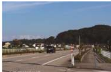
敷地境界部の白い柵
