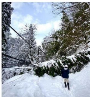
令和3年大雪 老谷地区における被害状況
