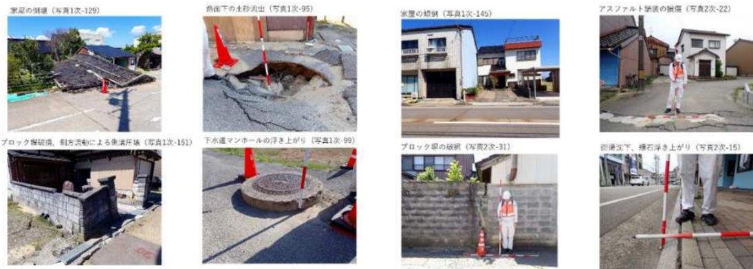
国土地理院における基盤地図情報(数値標高モデル5mメッシュ 国土地理院)と UAV レーザ計測(令和6年7月11~12日計測)結果を比較した結果、液状化調査エリアでは最大30cm程度の沈下が確認された。また、噴砂・めり込み沈下についても確認できた。
