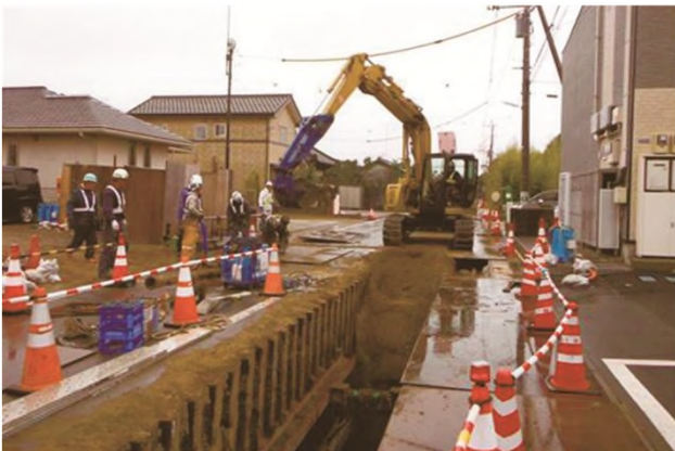
地下水位低下工法（開削）の工事風景
