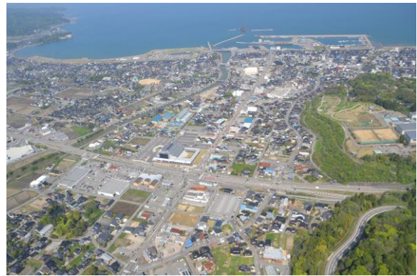
空から見た国道 415 号
