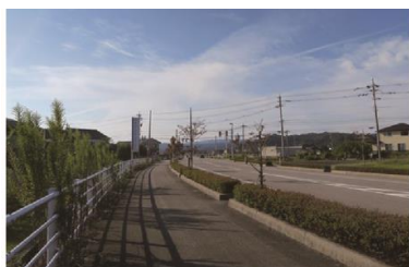
近接する道路の架空線
