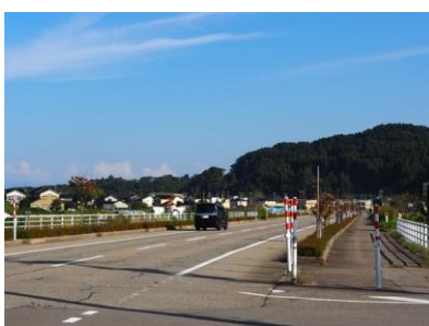
国道 415 号の街路樹と防護柵の現状
