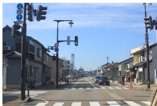
国道 415 号 (中央町)
