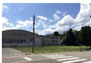
旧朝日丘小学校跡地
