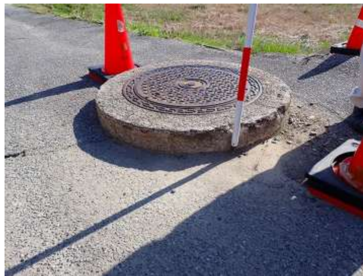
下水道マンホールの浮き上がり（写真1次-99）
