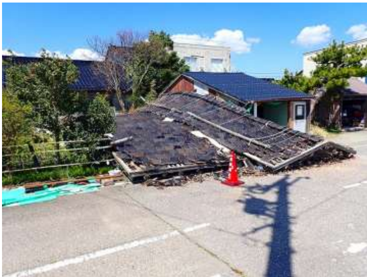
家屋の倒壊（写真1次-129）
