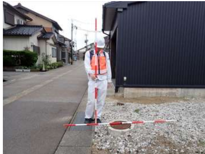
下水道宅内桧の浮き上り（写真2次-7）
