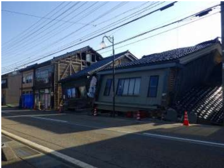
家屋の倒壊（写真2次-135）
