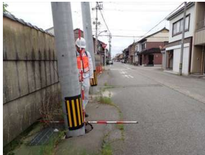
下水道宅内桧の浮き上り（写真2次-7）
