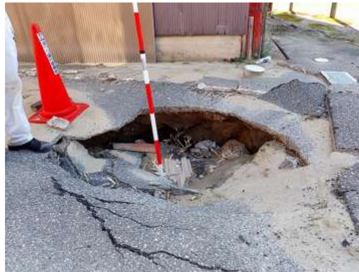
下水道マンホールの浮き上がり（写真1次-99）
