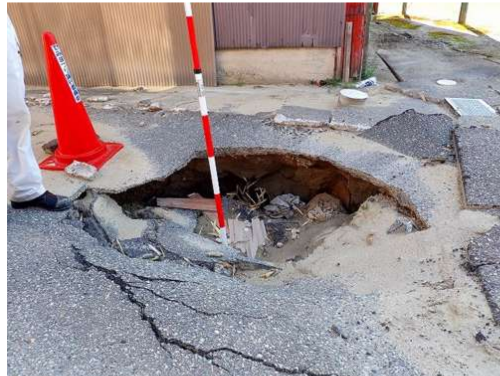
下水道マンホールの浮き上がり
