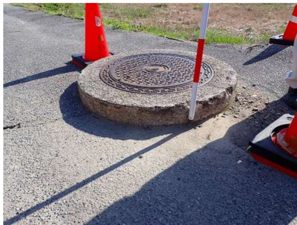
下水道マンホールの浮き上がり
