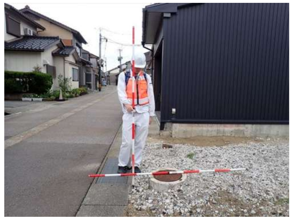
下水道宅内枳の浮き上り（写真2次-7）
