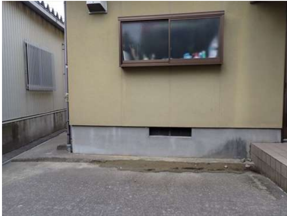
側溝と土間コンクリートとの開き（写真2次-4）
