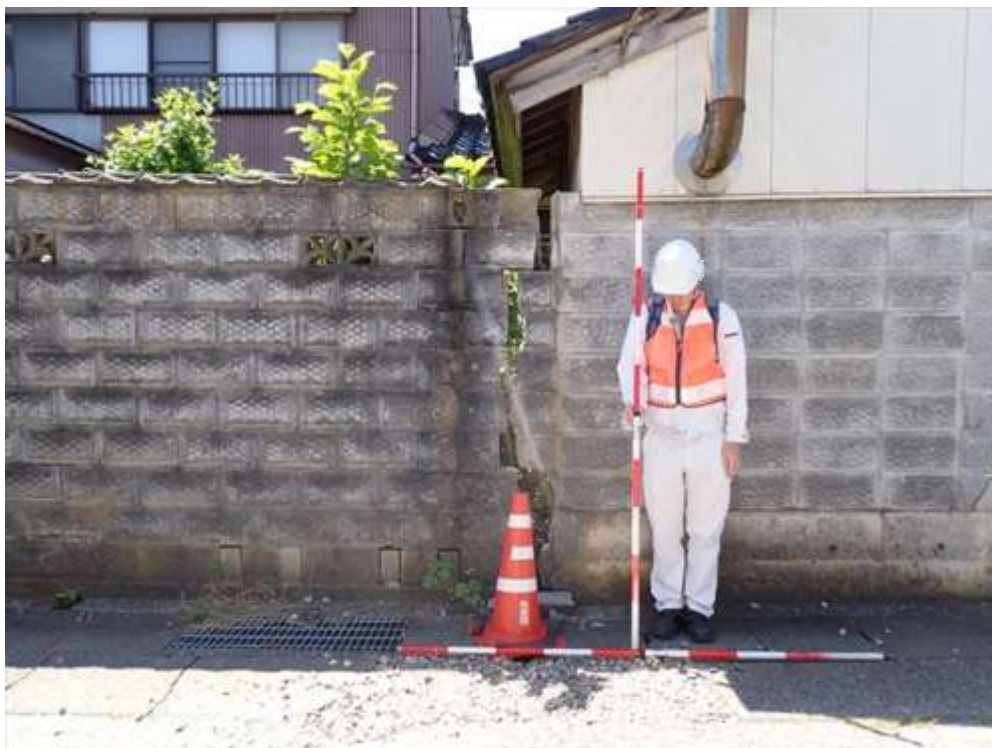
ブロック塀の破損（写真2次-31）
