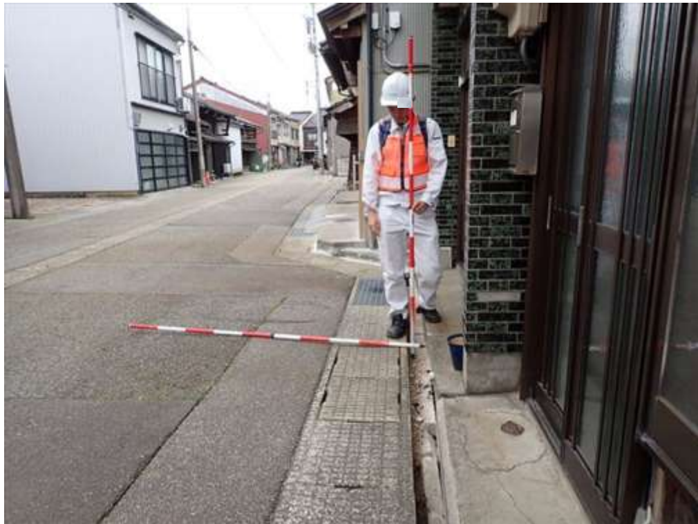
側溝と土間コンクリートとの開き（写真2次-4）
