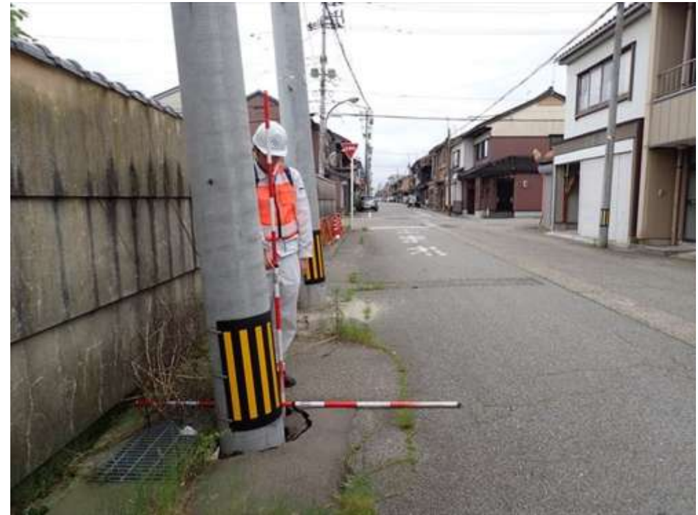
下水道宅内枳の浮き上り（写真2次-7）
