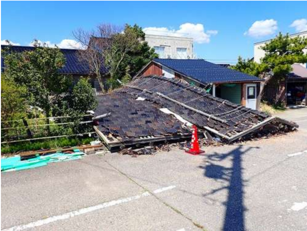
家屋の倒壊（写真1次-129）
