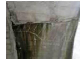
トンネルの「うき・ひび割れ」(対策を要する損傷、変状例)
