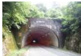
(百谷隧道の起点側坑門壁状況)
