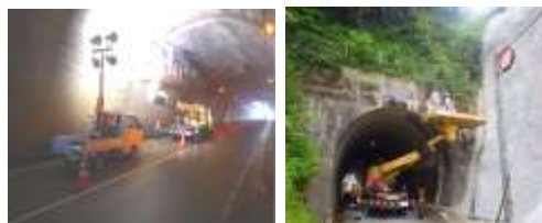
(トンネル覆工の点検状況)
