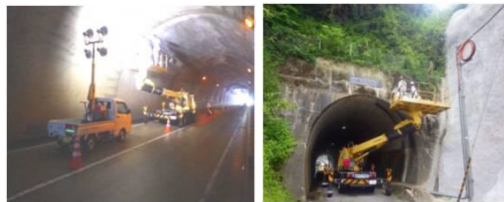
(トンネル覆工の点検状況)
