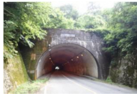
(百谷隧道の起点側坑門壁状況)
