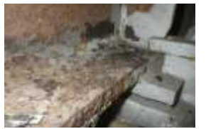
鋼材の腐食
