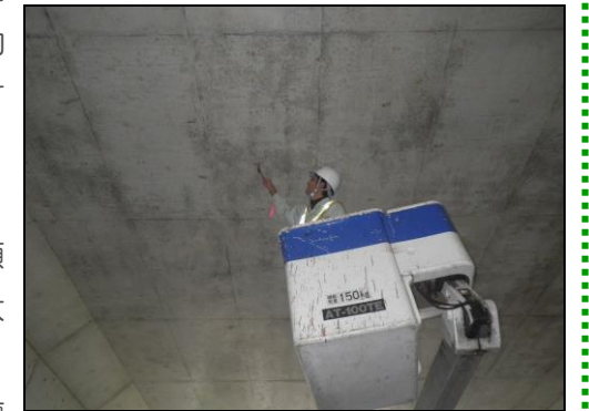
(頂版下面の点検状況)
