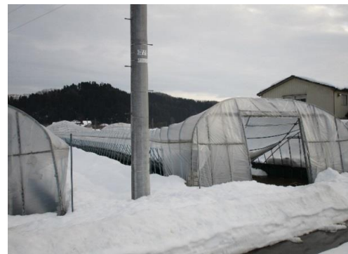
【大雪で倒壊したハウス(惣領)】
