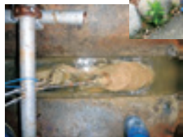
（写真上）ポンプの異物をとる作業 （下）下水管に引っかかったタオル
