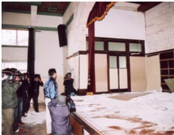
天井や壁の一部が崩落した旧稲積小学校校体育館
