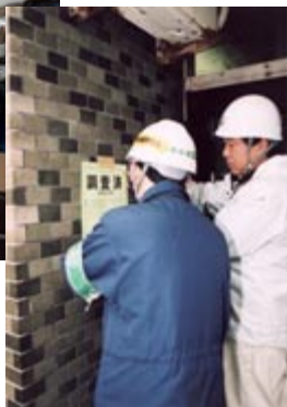
被災建物応急危険度判定を行う市職員ら
