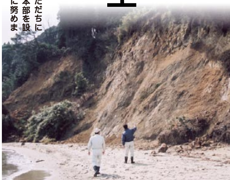
姿地内の海岸沿いのがけで発生した土砂崩れ
