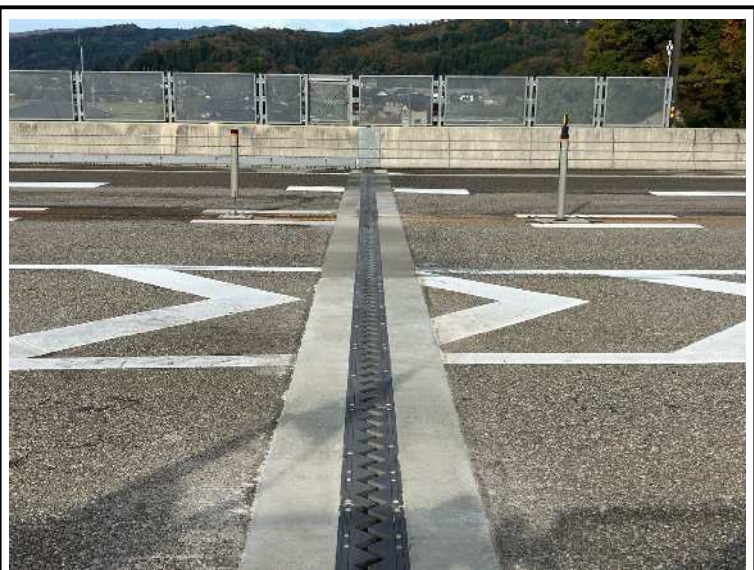
橋梁の補修状況
