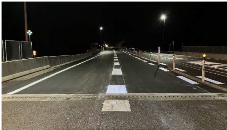
舗装の補修状況
