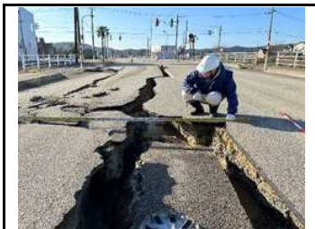
復旧現場の様子(市道環状北線)
