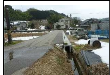
開水路⇒蓋掛水路への整備
