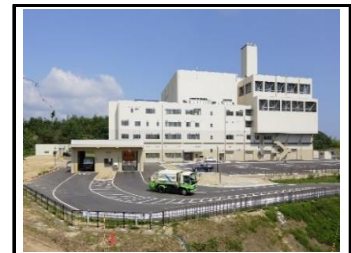
高岡広域エコ・クリーンセンター
