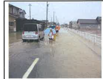
豪雨による浸水(道路)
