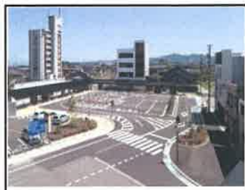
氷見駅前広場・周辺施設
