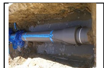
更新された配水管
