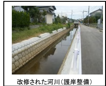
改修された河川(護岸整備)
