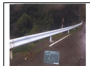
防護柵(ガードレール)の設置
