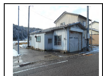
現在の上庄地区防災センター
