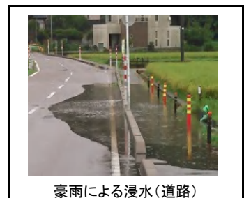
豪雨による浸水(道路)
