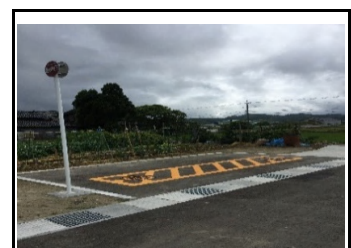
耐震性防火水槽
