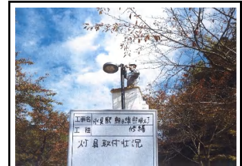
破損した街灯の取替
