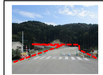
ふれあいの森へ整備が進む鞍川霊峰線BP
