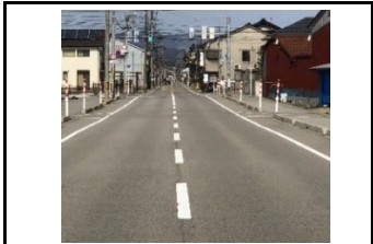
都市計画道路 [氷見伏木線] 写真手前は整備済 写真奥は未着手
