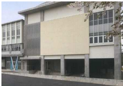
【南部中学校体育館の外観】
