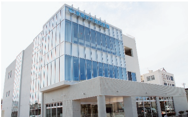
氷見伏木信用金庫本店 中央町 避難場所 3階大会議室・食堂
