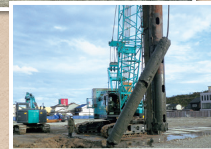
旧市民病院の建物を支えていた杭を抜く作業(令和2年11月撮影)
